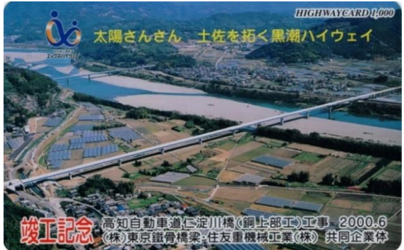
仁淀川橋 (2000年竣工) 高知県吾川郡いの町
