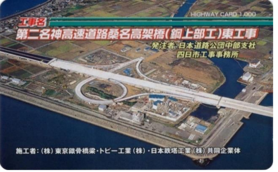
桑名高架橋 (2001年竣工) 三重県桑名市
