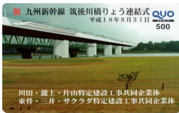
筑後川橋りょう(2006年竣工) 佐賀県鳥栖市~福岡県久留米市
