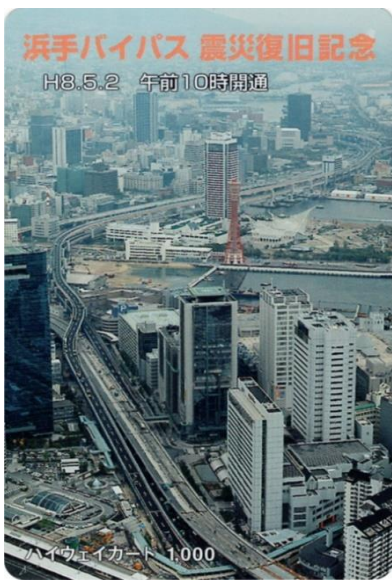
浜手バイパス震災復旧 (1996年竣工) 兵庫県神戸市中央区
