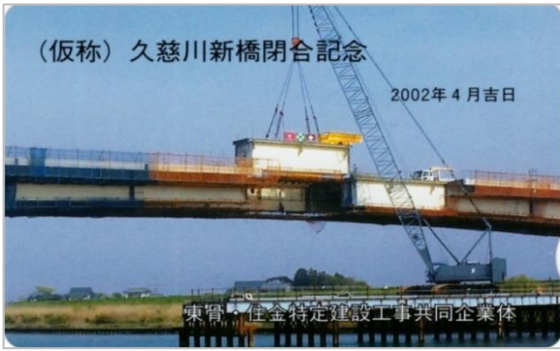
久慈川新橋(2002年竣工) 茨城県那珂郡東海村
