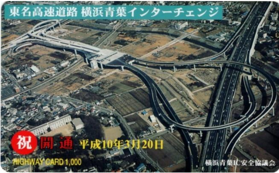
東名高速道路 横浜青葉IC (1998年竣工) 神奈川県横浜市
