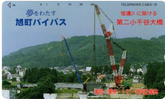
第二小千谷大橋 (1999年竣工) 新潟県小千谷市
