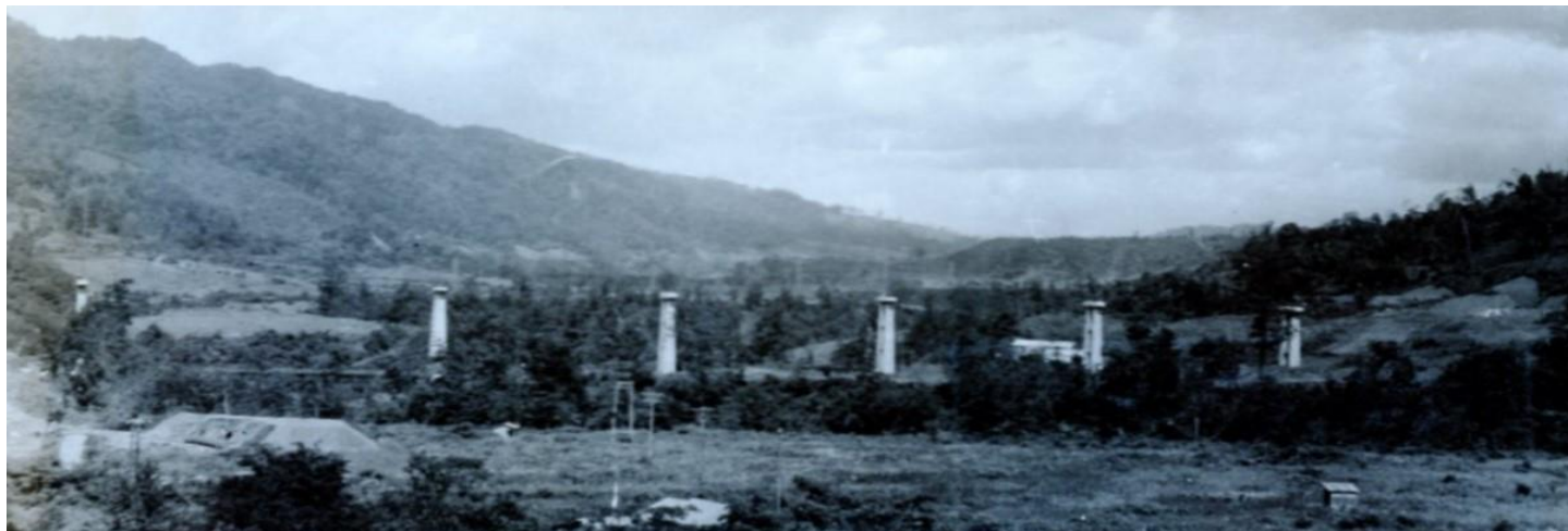
架設現場(遠景)～架設前の状態
