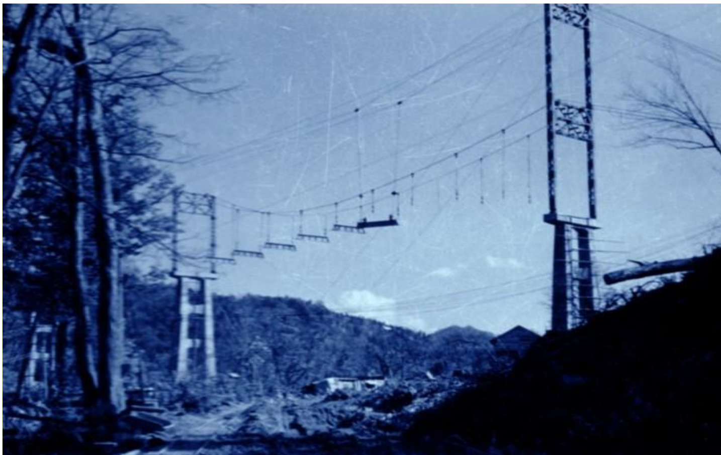
ワイヤークリップ取付作業
