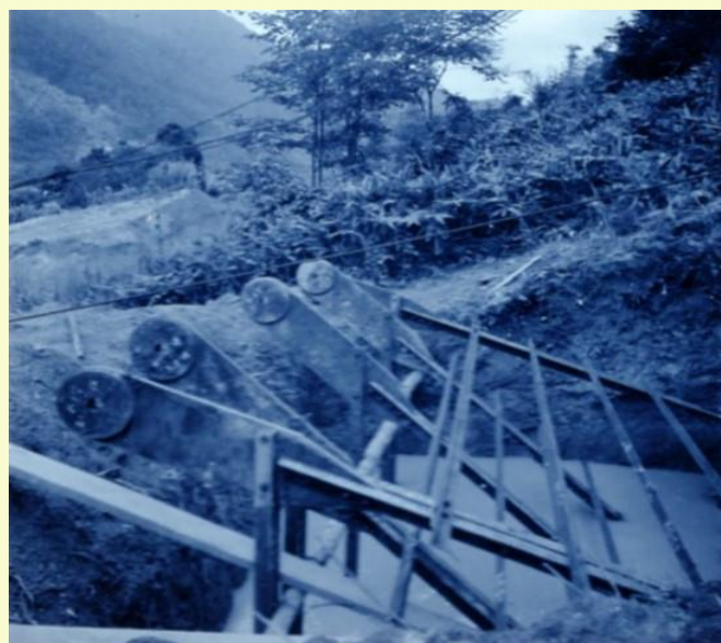
アンカーコンクリート打ち(左岸)
