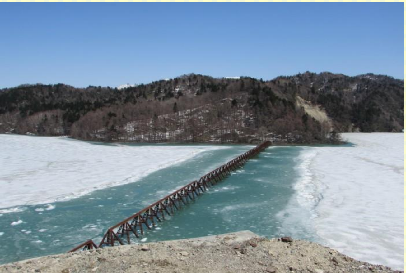
ダム湖に沈む三弦橋
