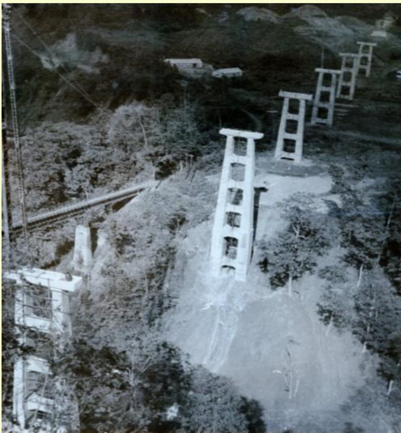
架設現場(近景)～下部工
