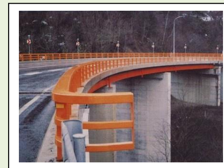
40. 赤岩橋（1991年完成） 型式：連続曲線鋼桁 橋長：140m 所在地：占冠村
