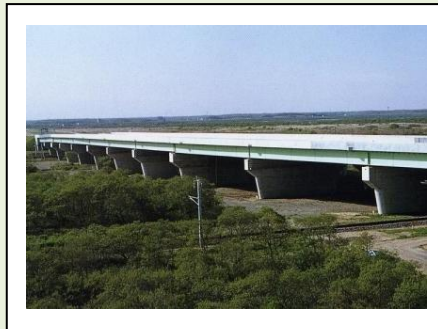
37. チマイベツ川橋（1990年完成） 型式：連続鋼桁 橋長：269m 所在地：伊達市
