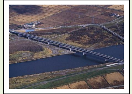
43. ハカイマップ橋（1993年完成） 型式：単純鋼桁 橋長：49.0m 所在地：今金町
