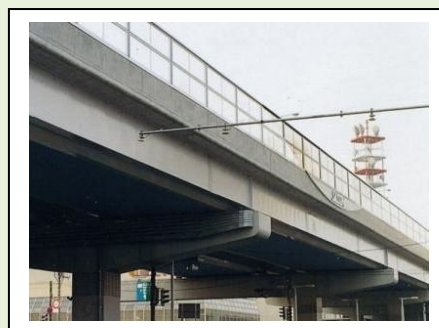
41. 麻生西IC高架橋（1992年完成） 型式：連続鋼桁 橋長：100m 札幌市北区
