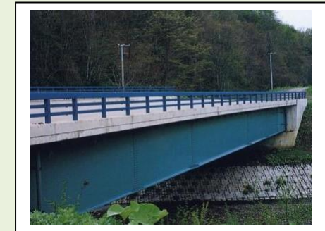
44. 富良野五条大橋（1993年完成） 型式：ローゼ桁、連続箱桁、他 橋長：240.5m 所在地：富良野市
