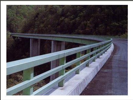
36. ウトナイ高架橋（1990年完成） 型式：連続鋼桁 橋長：371.2m 所在地：苫小牧市
