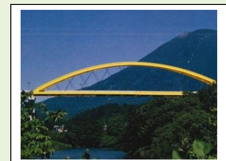
45. ニセコ大橋（1994年完成） 型式：ニールセンローゼ桁、他 橋長：380m 所在地：虻田郡ニセコ町
