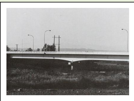
5. 本別大橋 (1973年完成) 型式：2径間連続箱桁 橋長：112m 所在：中川郡本別町
