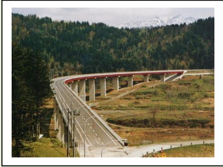
24. 両神橋 (1986年完成) 型式：単純鋼床版箱桁、連続钣桁 橋長：261m 所在地：旭川市
