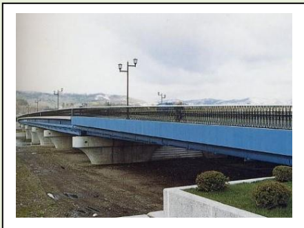
25. 中央橋 (1987年完成) 型式：鋼床版箱桁 橋長：62m 所在地：岩見沢市
