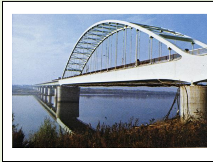
3. 新石狩大橋 (1968年完成) 型式：5径間連続合成桁、バランスドラングアーチ、他 橋長：917m 所在地：江別市
