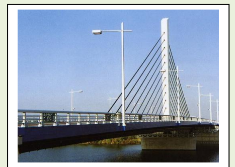
34. 花畔大橋 (1990年完成) 型式：斜張橋 (連続鋼床版箱桁) 橋長：230m 所在地：石狩町
