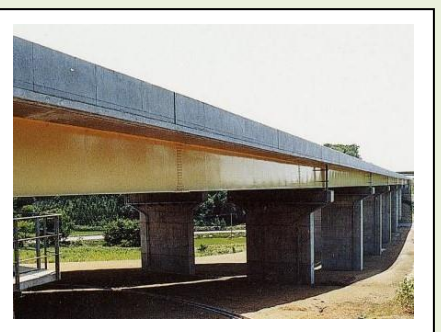
26. 東利根別高架橋 (1987年完成) 型式：連続钣桁 橋長：278.2m、286.2m 所在地：岩見沢市
