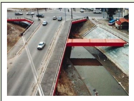
26. 東利根別高架橋 (1987年完成) 型式：連続钣桁 橋長：278.2m、286.2m 所在地：岩見沢市
