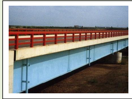
28. 新白雲橋 (1988年完成) 型式：単純合成钣桁、ローゼ桁 橋長：135m 所在地：河東郡鹿追町
