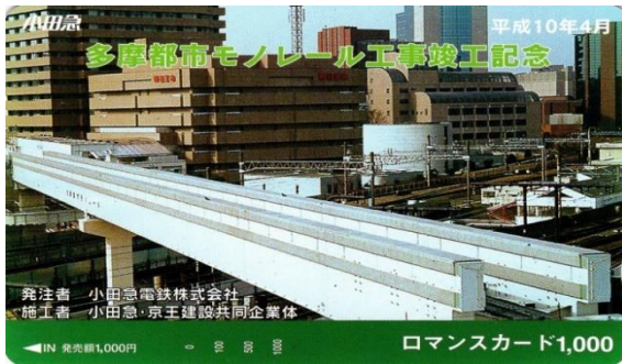
多摩モノレール工事 (1998年竣工)
