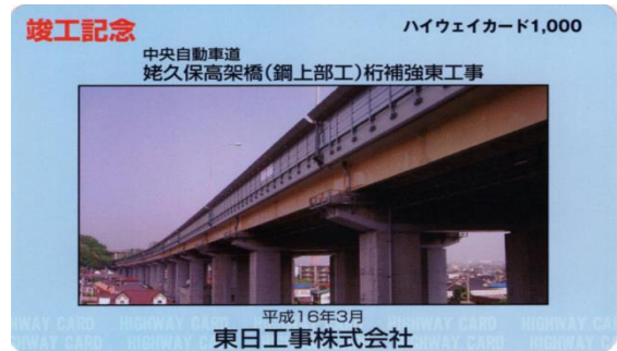
姥久保高架橋(東日工事) (2004年竣工)
