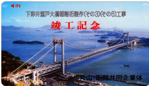
下津井瀬戸大橋(1988年竣工) 岡山県倉敷市～香川県坂出市
