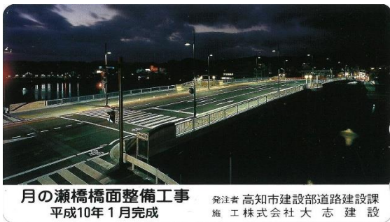
月の瀬橋(1998年完成) 高知県高知市
