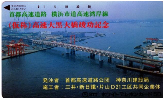
大黒大橋(1989年竣工) 神奈川県横浜市鶴見区名港
