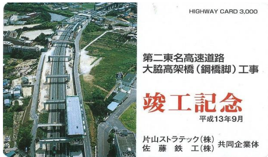
大脇高架橋(2001年) 愛知県大府市～豊明市
