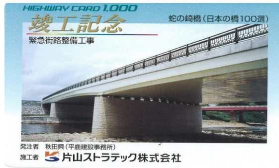
蛇の崎橋(2001年竣工) 秋田県横田市
