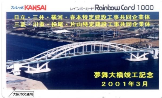
夢舞大橋(2001年竣工) 大阪府大阪市此花区
