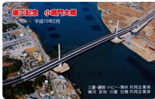
小鳴門大橋(1998年竣工) 徳島県鳴門市瀬戸町
