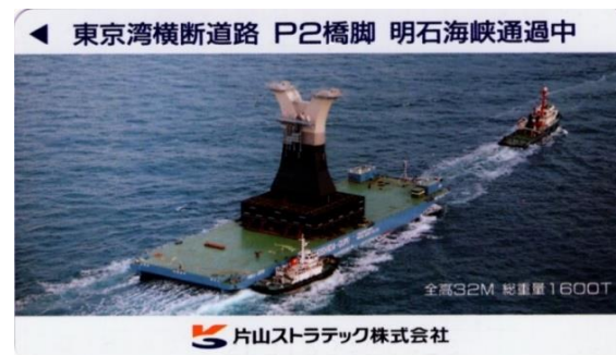
アクアブリッジ橋脚(1991年竣工) 千葉県木更津市
