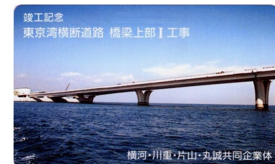
アクアブリッジ上部工(1995年竣工) 千葉県木更津市
