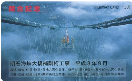
明石海峡大橋(1996閉合) 兵庫県神戸市～淡路市
