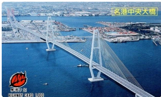
名港中央大橋 西塔(1998年竣工) 愛知県名古屋市港区
