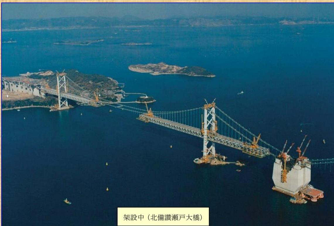
本四架橋3ルートのうち、香川県坂出市与島町に位置する「児島-坂出ルート」に架かる中央径間990m、全長1,518mの道路・鉄道の併用橋(型式は3径間連続補剛桁吊橋)。
