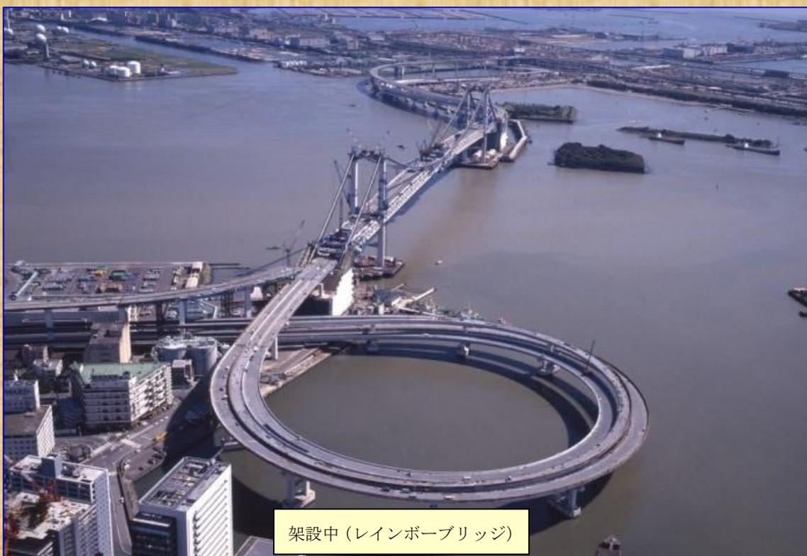
東京都心部(芝浦地区)と当時開発中であった埋立地(お台場地区)を結ぶ臨港道路・高速道路・新交通システムの3路線からなる世界的にも珍しい複合交通施設として計画された海上部に架かる橋長 798m の 3 径間 2 ヒンジ補剛トラス(二層構造)の吊橋です。吊橋部の施工は 5JV(全 14 社)が分割受注し、当社は芝浦側の側径間補剛桁(114m)と中央径間の下層鋼床版桁部分の施工を担いました。
