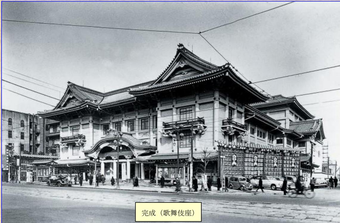
建造中に関東大震災で被災し、そして1945(昭和20)年にはB29の空爆によって壊滅的な被害を受けた3代目歌舞伎座の復旧工事です。奇跡的に残った外壁を利用して、それまでの歌舞伎座の外観デザインを踏襲した桃山時代を想起させる優雅な造りとなっています。
