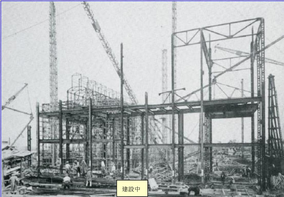
関東大震災後の帝都復興を目指して完成を急がされました。そのため、芝浦の工場だけでは製作が間に合わず、現地の河岸に応急的な仮工場を建てて昼夜二交代の突貫工事で行われました。
