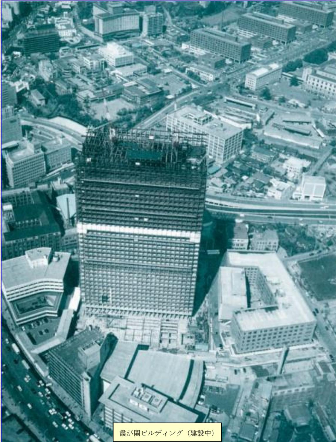
官公庁が集まった霞ヶ関に位置する超高層ビルであり、その規模は地上 36 階建・高さ 147mです。それまでのビルに比べて飛び抜けた高さ、いわゆる“柔構造”を採用した点で、「超高層時代」の先駆けとなりました。また、日本で 100mの高さを超えた初めてのビルでもあり、完成から数年の間は多くの東京見物の観光客がそのビルの最上階に設けられた展望台に訪れ、東京タワーよりも人気を集めました。
