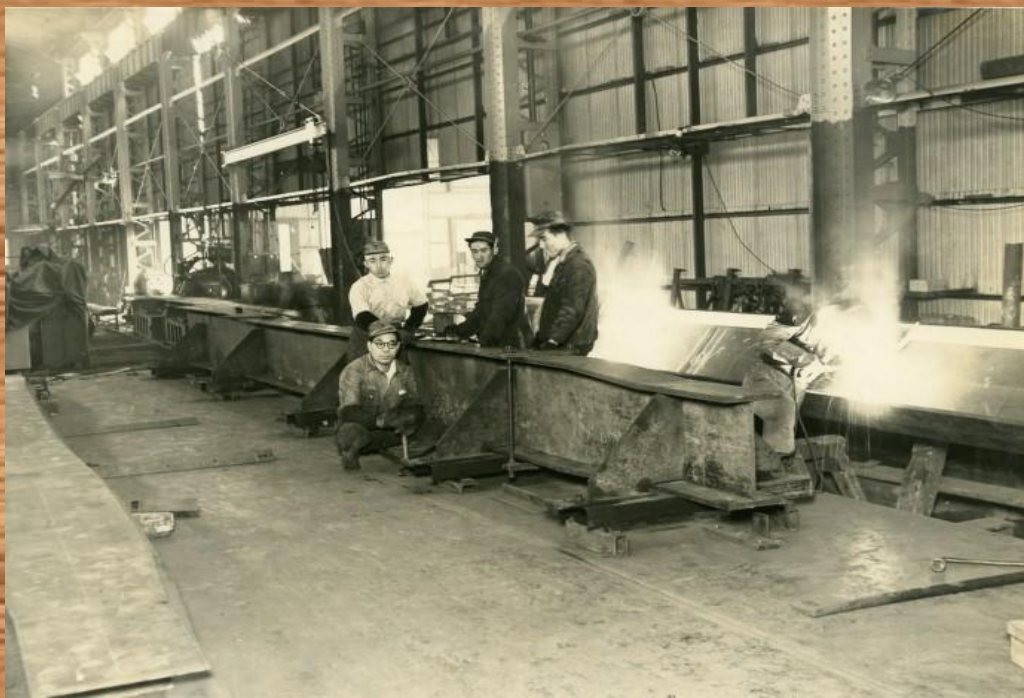
1956年 芝浦工場 溶接作業
