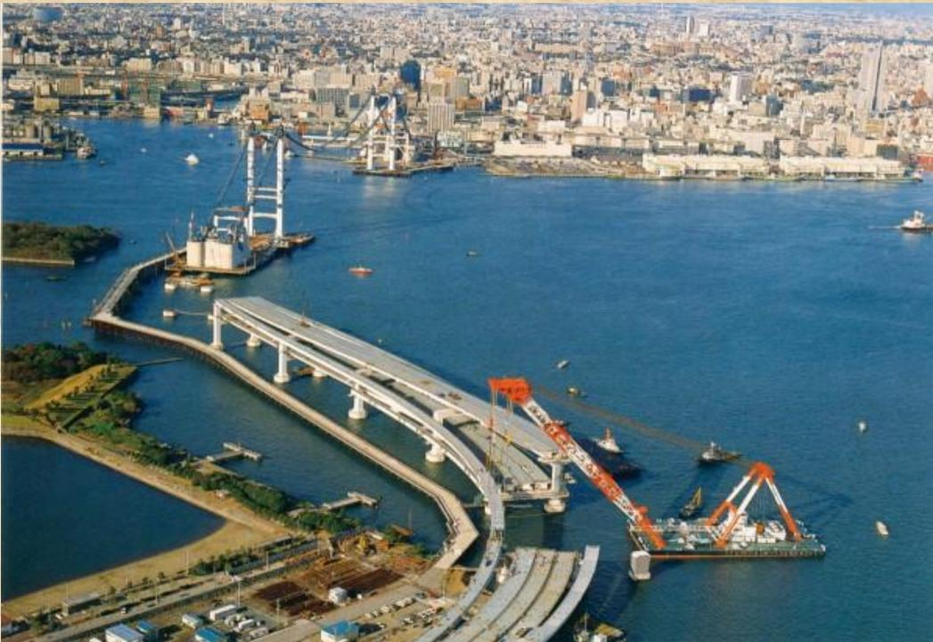
東京都港区の芝浦地区と台場地区との間にある第一航路上に架橋された中央径間570m、全長798.0m、幅員29.0mの3径間2ヒンジ補剛トラス(二層構造)吊橋。
