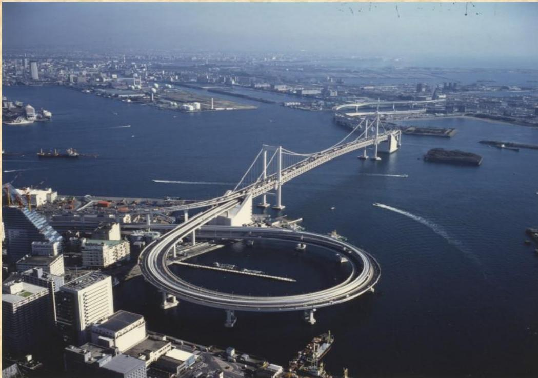
レインボーブリッジは、首都圏で建設される初めての吊橋で、21世紀の国際都市・東京の新しいシンボルとなるもの。東京都心部と臨海部副都心の13号埋立地とを結ぶ臨港道路、高速道路、新交通システムからなる複合交通施設として計画された。補剛トラスと床組を合わせて約24,000tの製作を6社で行うもので、当社は芝浦側の側径間(114m)を担当した。製作は、輸送可能な部材(主に鋼床版)は取手工場、その他の鋼床版と補剛トラスは千葉臨海工場を担当した。(「社報129号」より)
