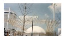
テーマは「人間・ゆめ・技術」。 建物の壁面には滝が流れ、高さ 15m に位置する幅 5.3mのテンセグリティ構造体を応用したフレームが宙に 浮いているような建物でした。
