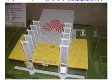
テーマは「健康とスポーツを科学する」。42 面の動くスクリーンを使った映像が評判を呼び、観客動員数は全パビリオンの中で最大でした。3 棟の建物を間に立つ柱から伸びたワイヤーが支える構造でした。
