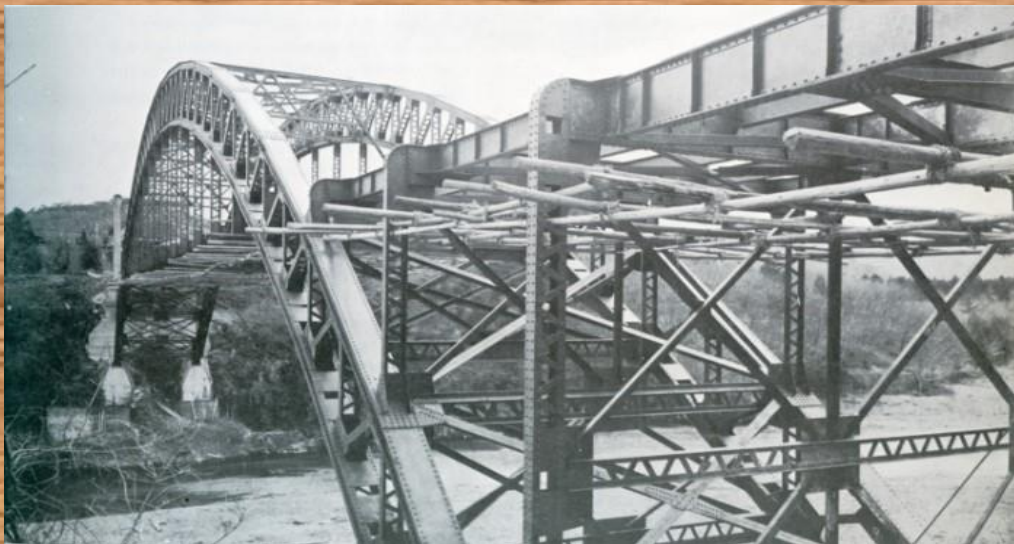
調布橋 受注: 1934年(昭和9年) 工事場所: 青梅市、多摩川 規模: 103.3m × 6.5m 型式: 鋼中路2ヒンジブレースドリブアーチ橋
