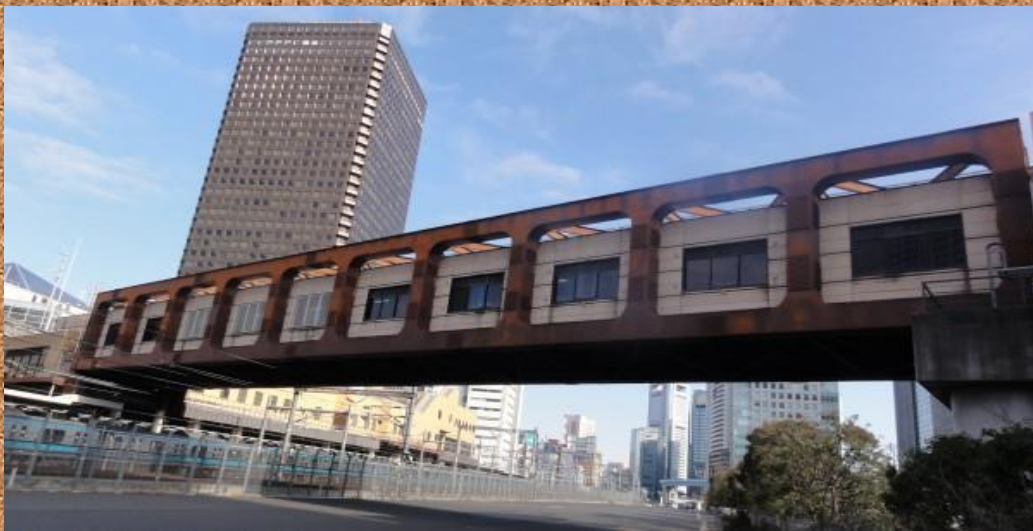
浜松町駅構内跨線人道橋(現在)
