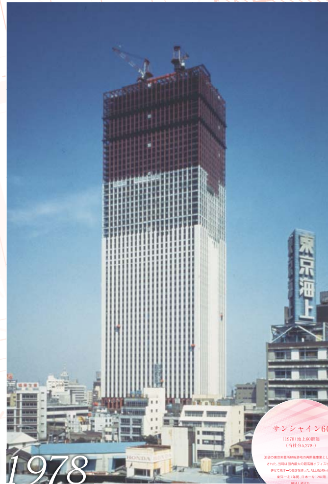
京王プラザホテル (1971)地上47階建 (総面積9,000㎡、当社分920㎡) 新橋駅南口の中央に建つ高さ170mの超高層ビル。 設備等全層の両側面により生まれながら新設超高層 ビル初の両側面開放性、日本初の両側面ガラス として関東圏の建築界への先導 を果たした。
