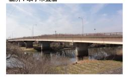
これも小貝川を渡る部分に架かる 橋で、県道210号(谷田部藤代線) に架かる橋長212mの3径間連続 鈑桁橋です。なお、この橋は藤代小 学校に近接した場所にあります。
