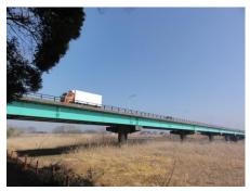
稲豊橋は、県道328号(谷井田 稲戸井停車場線)の小貝川を渡る部 分に架かる橋で、単純合成鈑桁6連 からなる橋長217mの橋です。
