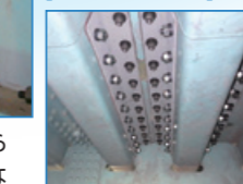
Uリブ鋼床版下面補強工法
