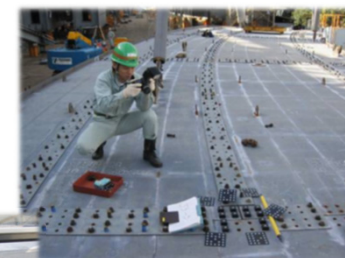
後製作添接板の計測
