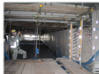
下部工鉄筋の計測
